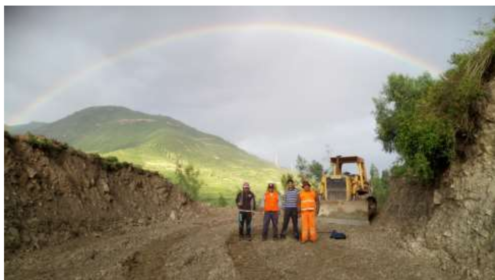
Ingeniero José Carlos Maldonado Mendivil, junto a los trabajadores de la obra
