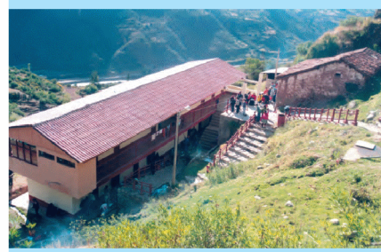
Modernas instalaciones de los baños termales de Pincahuacho.
