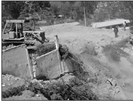
Demolición del Templo del "Señor Animas" de Chalhuanca
